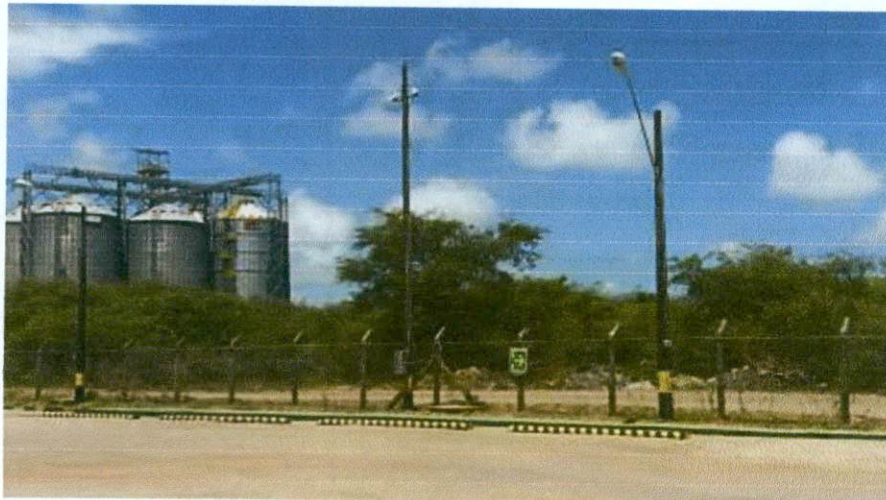
Figura 18 – Cercamento e Segurança.
