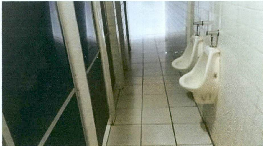
Figura 15 – Água e Esgoto.
